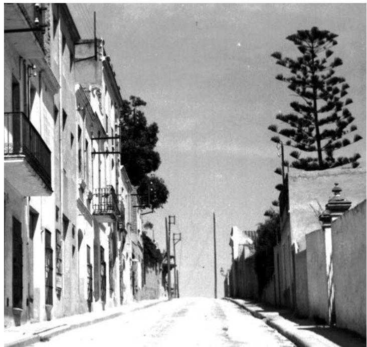
Sector del carrer Lluís Millet on hi ha el repartidor general de la mina Murot-Patrana.
