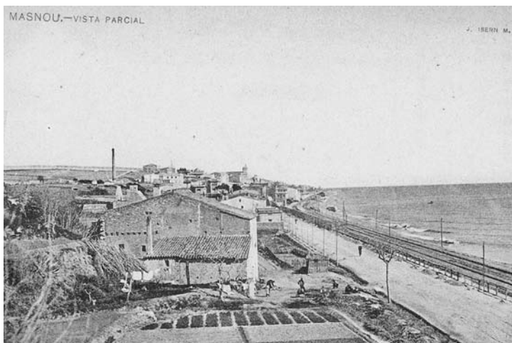
Vista del Masnou des de Can Teixidor
