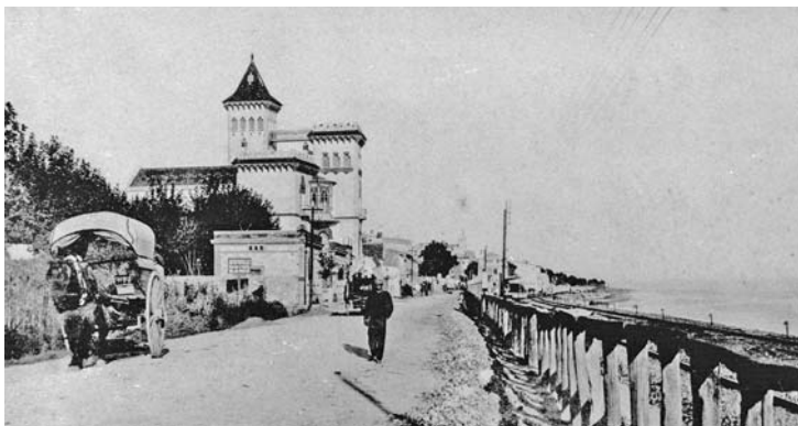
Vista de la carretera abans del 1912. Abans del «Castellet», podem veure la porteria, a l'entrada de la finca Bell Esguard quan no hi havia encara el mur.
