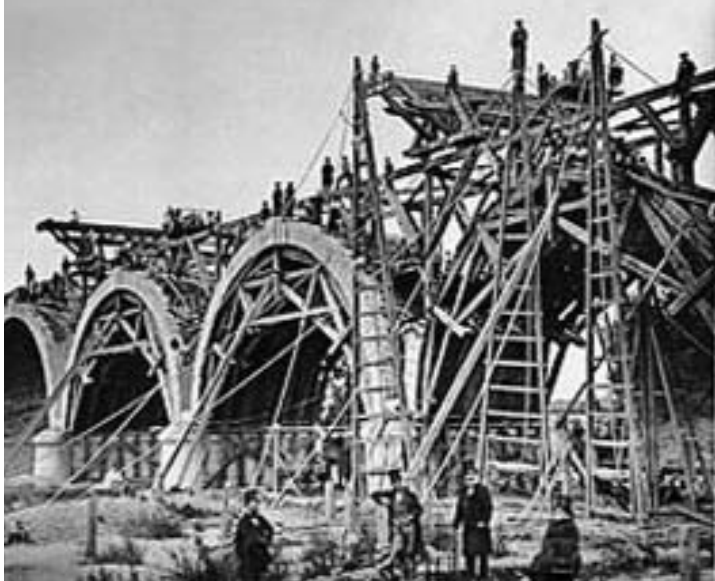
Construcció del Pont des Francesos per al ferrocarril a Madrid el 1859
