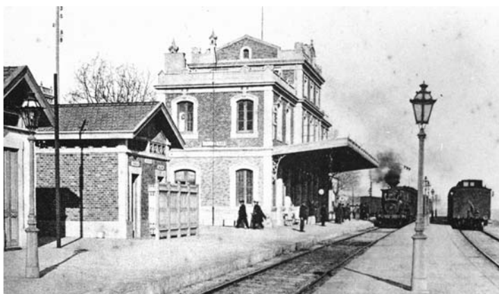
Estació del Masnou. Començament s.xx.
