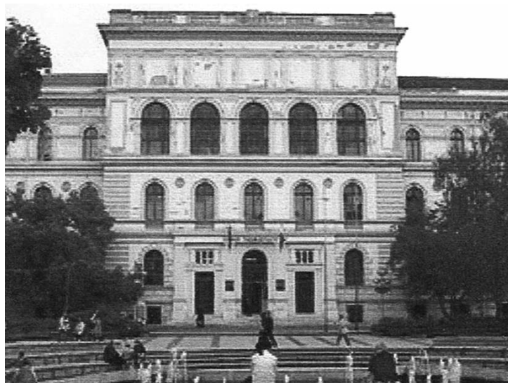
Edifici central de la Universitat de Szeged
