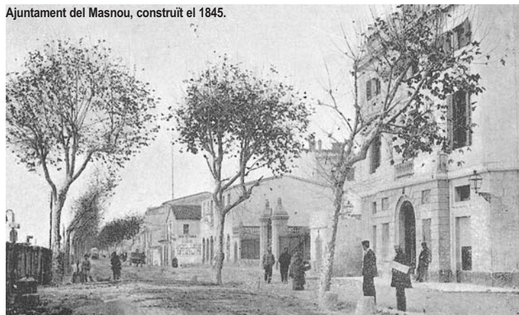
Ajuntament del Masnou, construït el 1845.
