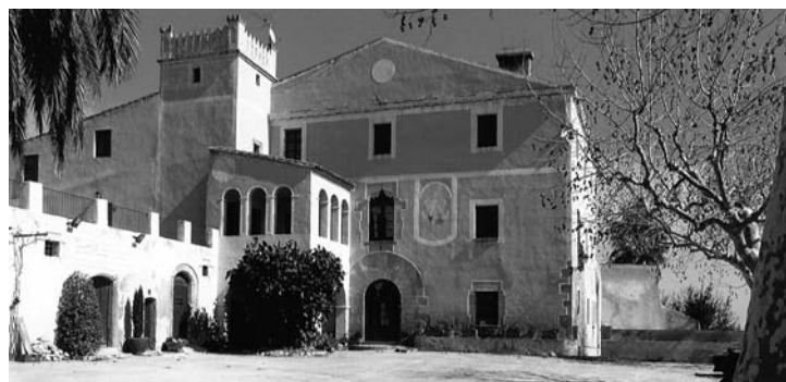
Vista de la masia des de l'entrada
